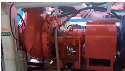
徐州市政工程排水小隧道 Xuzhou Municipal Engineering Drainage Small Tunnel
