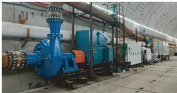
上海基础建设15米隧道项目 Proyecto de túnel de 15m de infraestructura en Shanghai
