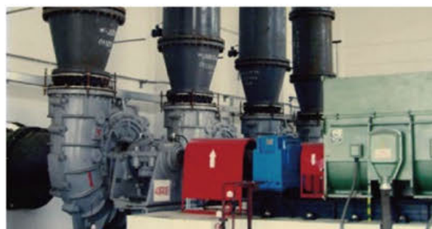
山东潍坊电厂 脱硫现场 Proyecto de planta de energía en Weifang, Shandong
