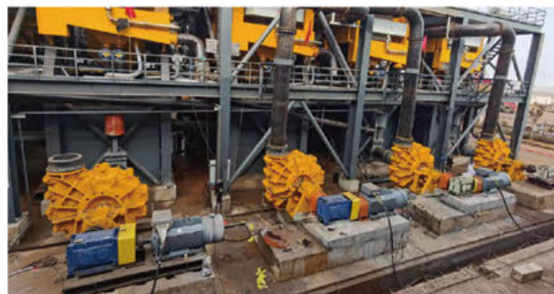
连云港矿山项目 Proyecto de la mina Lianyungang
