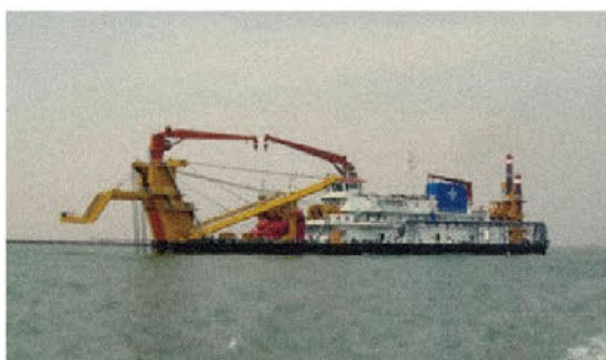
"Tian Ji" de la Oficina de Vías Navegables de Tianjin de la CCCC
