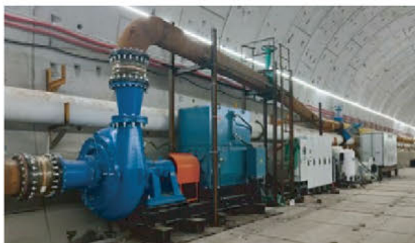
Proyecto de Infraestructura de Shanghai Túnel de 15 metros
