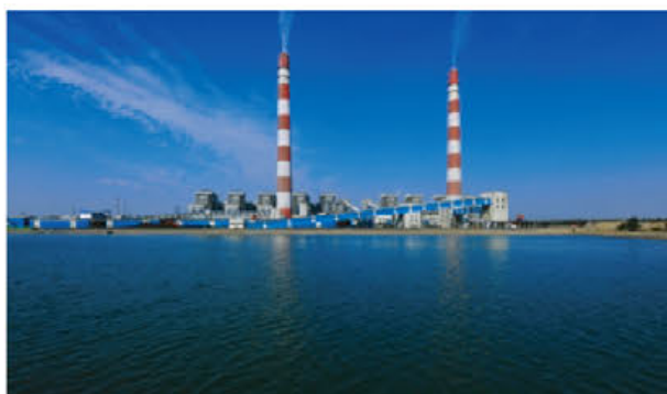
Central eléctrica de Jasukuda, India
