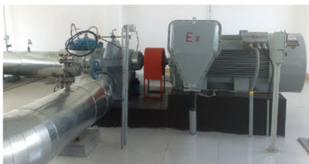
Проект доставки нефти на нефтебазу в Циндао 青岛油库输油泵项目
